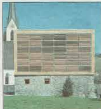
Bei starker Sonneneinstrahlung werden alle Lamellen geschlossen.
